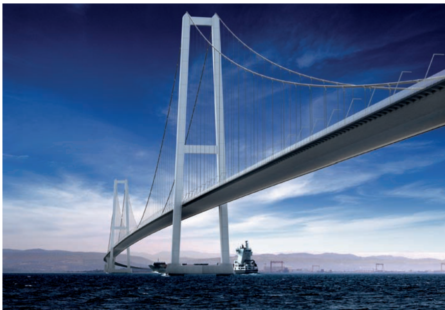
Izmit Bay Bridge, Turkiet
